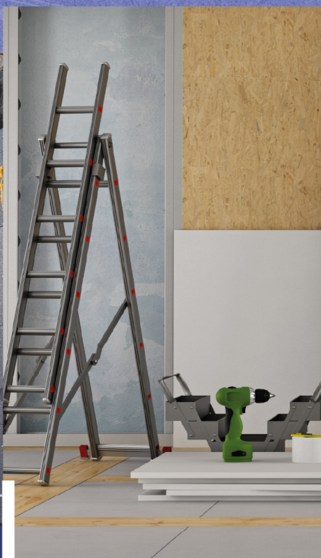
REMISE EN ÉTAT D'UN LOGEMENT DÉGRADÉ
