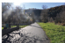
Travaux de voirie
