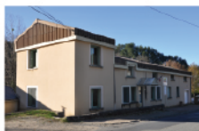
Rénovation du siège de la ComCom
